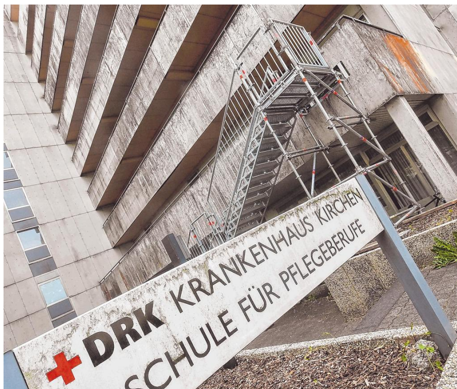
Kein schöner Anblick: die alte Pflegeschule an der Kirchener Sandstraße. Aber die Chancen stehen gut, dass auf dem Areal an der alten Heizzentrale eine neue Ausbildungsstätte geschaffen wird. Foto: damo
